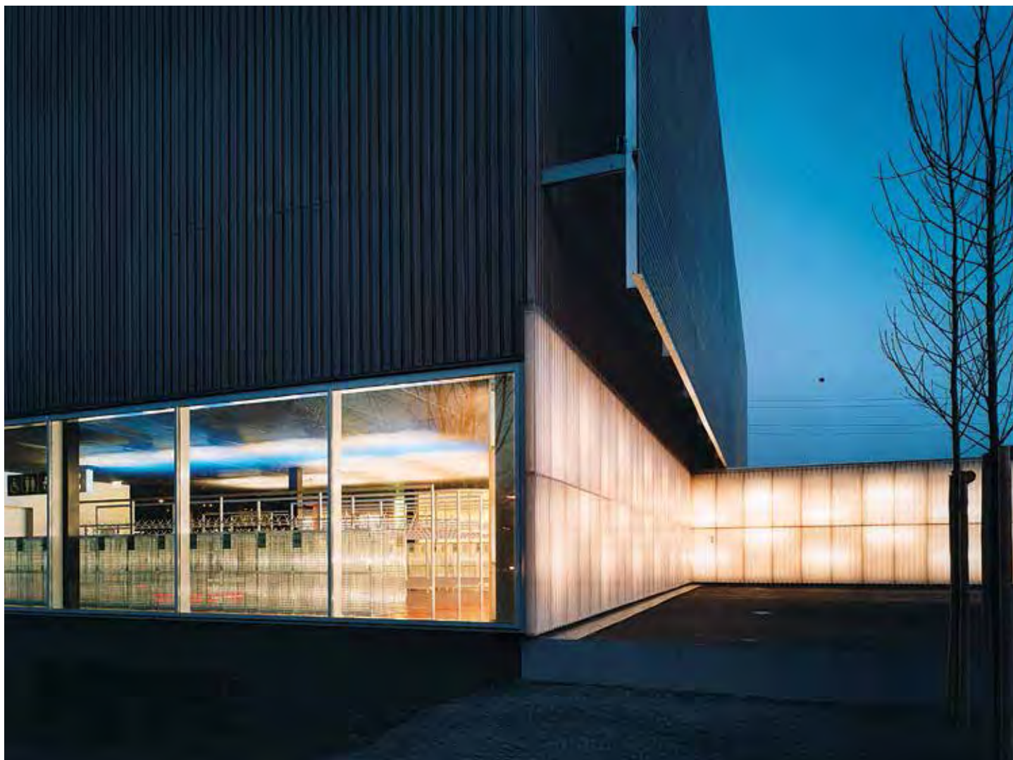
Abbildung 8.10: Lichtwirkung der in der Zwischenschicht eingebrachten Leuchtstofflampen nach innen und ausseren.
