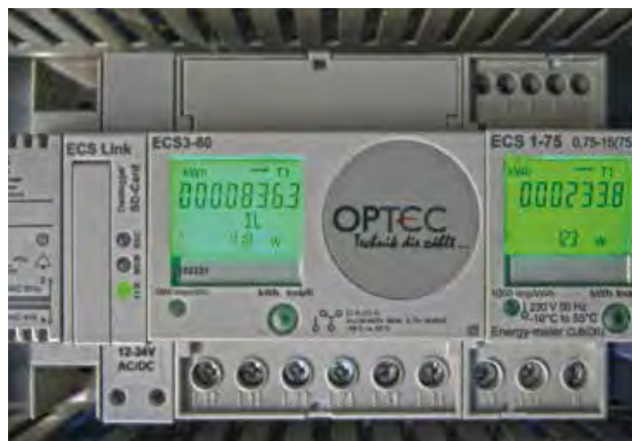
Abbildung 6.22: Energie- und Leistungsmessgerät mit Datenlogger für SD-Karte.
