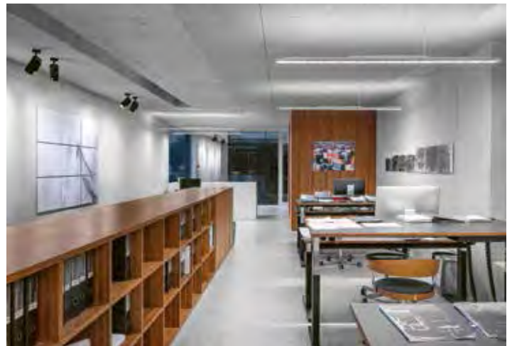
Abbildung 8.33: Büro Lichtkonzept: Pendelleuchten/ Aufbaustrahler. (Bild Zumtobel)
